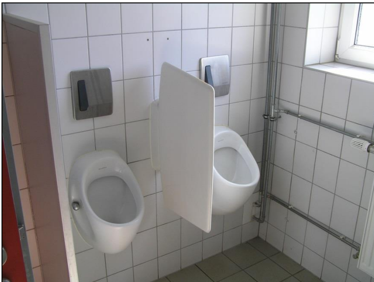
Abbildung 12: Sportheim Jenzigweg, Sanitärraum
