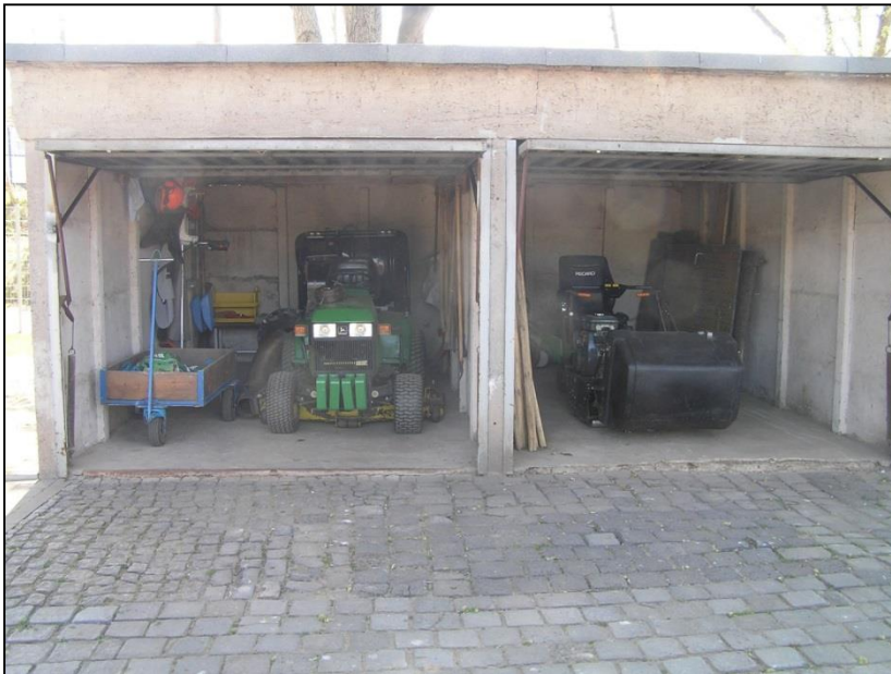
Abbildung 13: Kalträume Jenzigweg, Garagen
